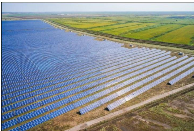
Рис. 1. Сонячна електрична станція «Приозерна», Кілійський район Одеська область
